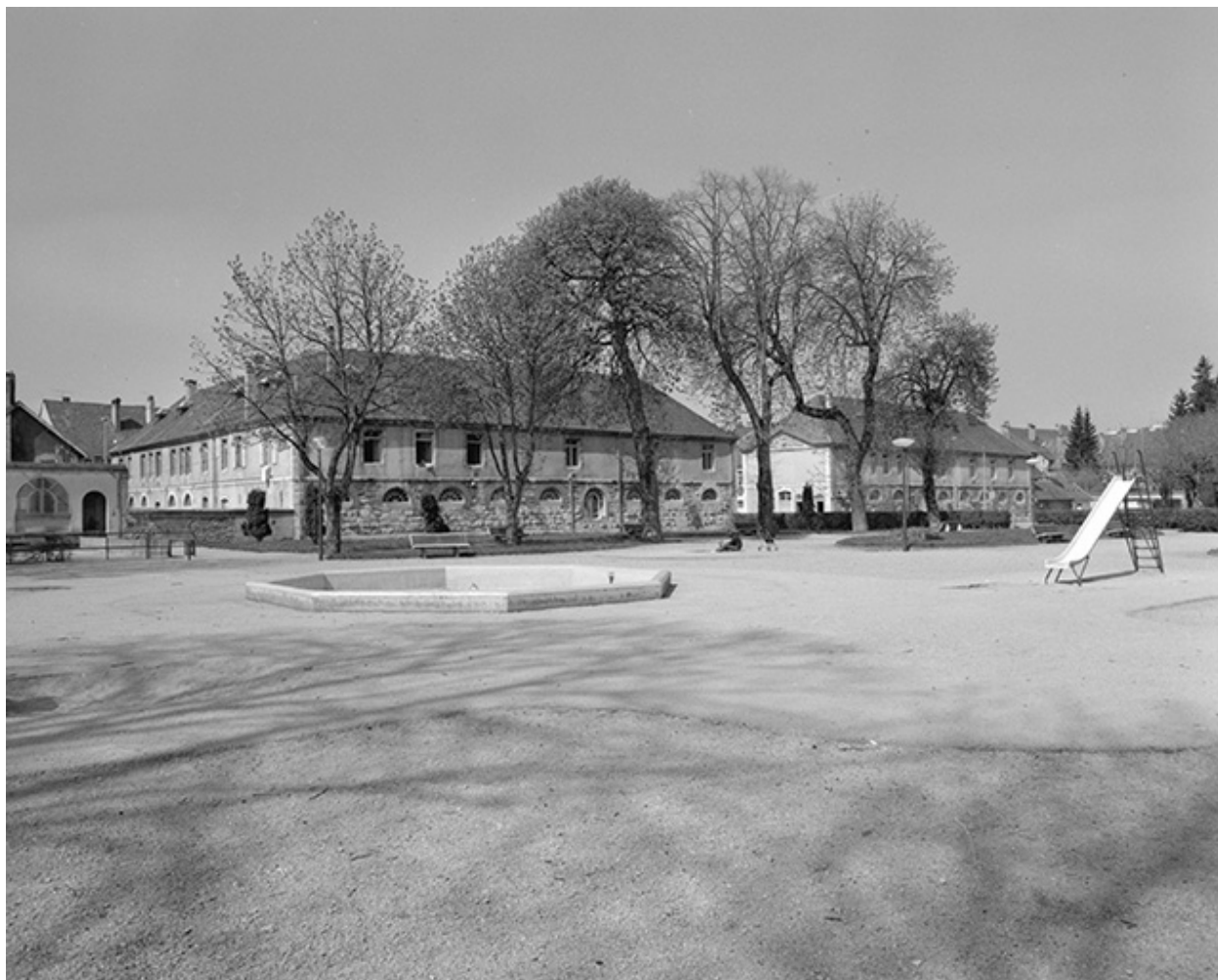
Vue d'ensemble de la façade postérieure.
