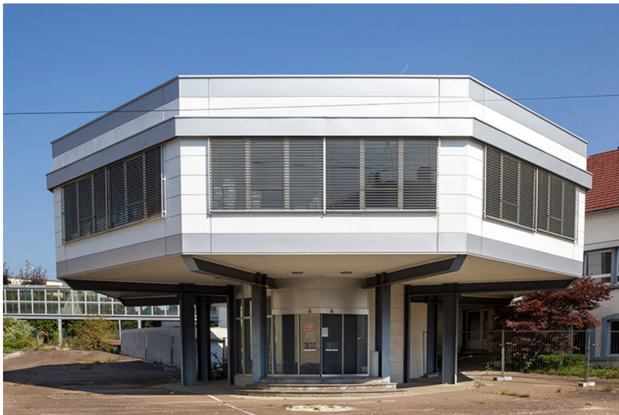
Usine : corps d'entrée.
