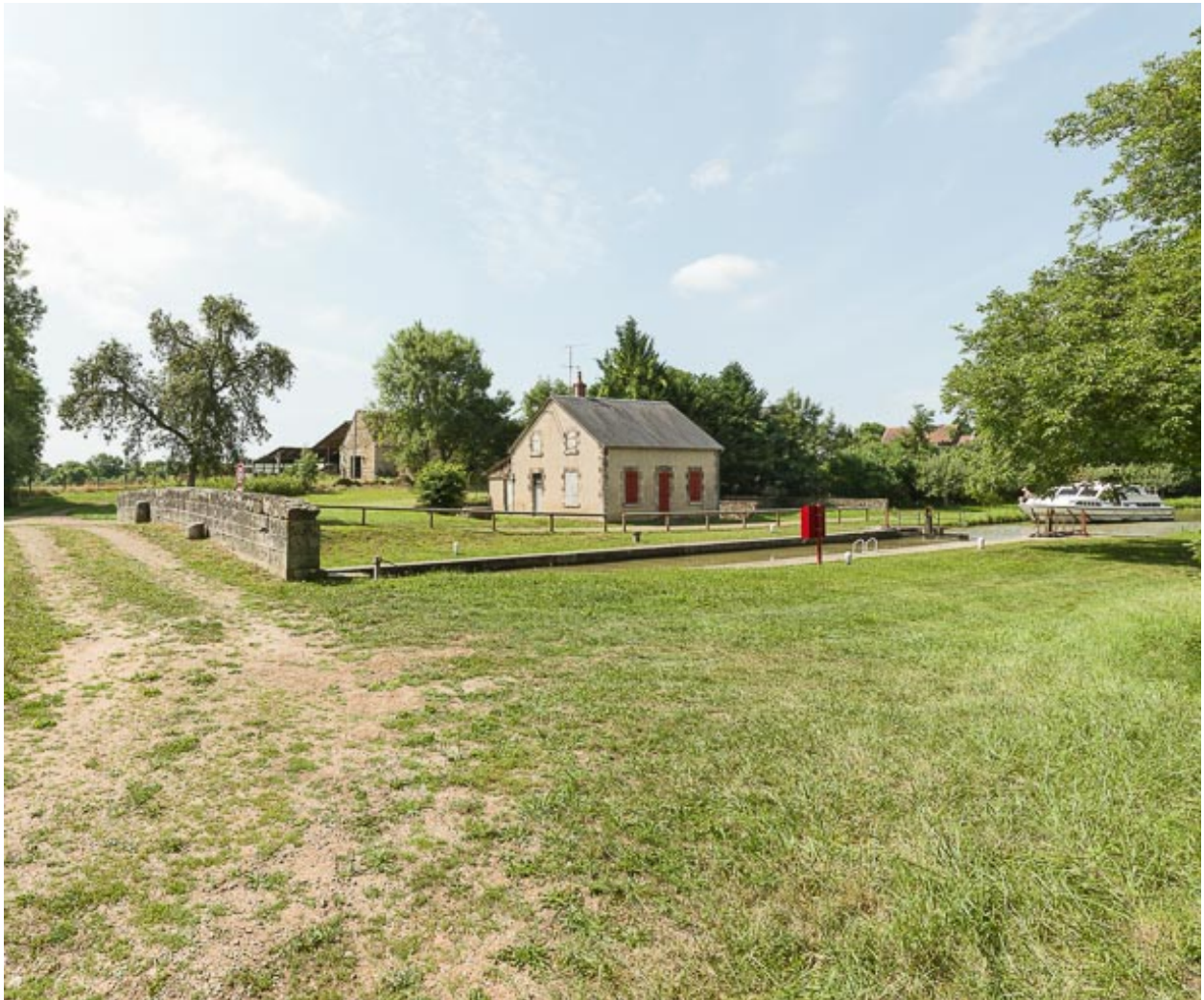
Vue du site d'écluse.
