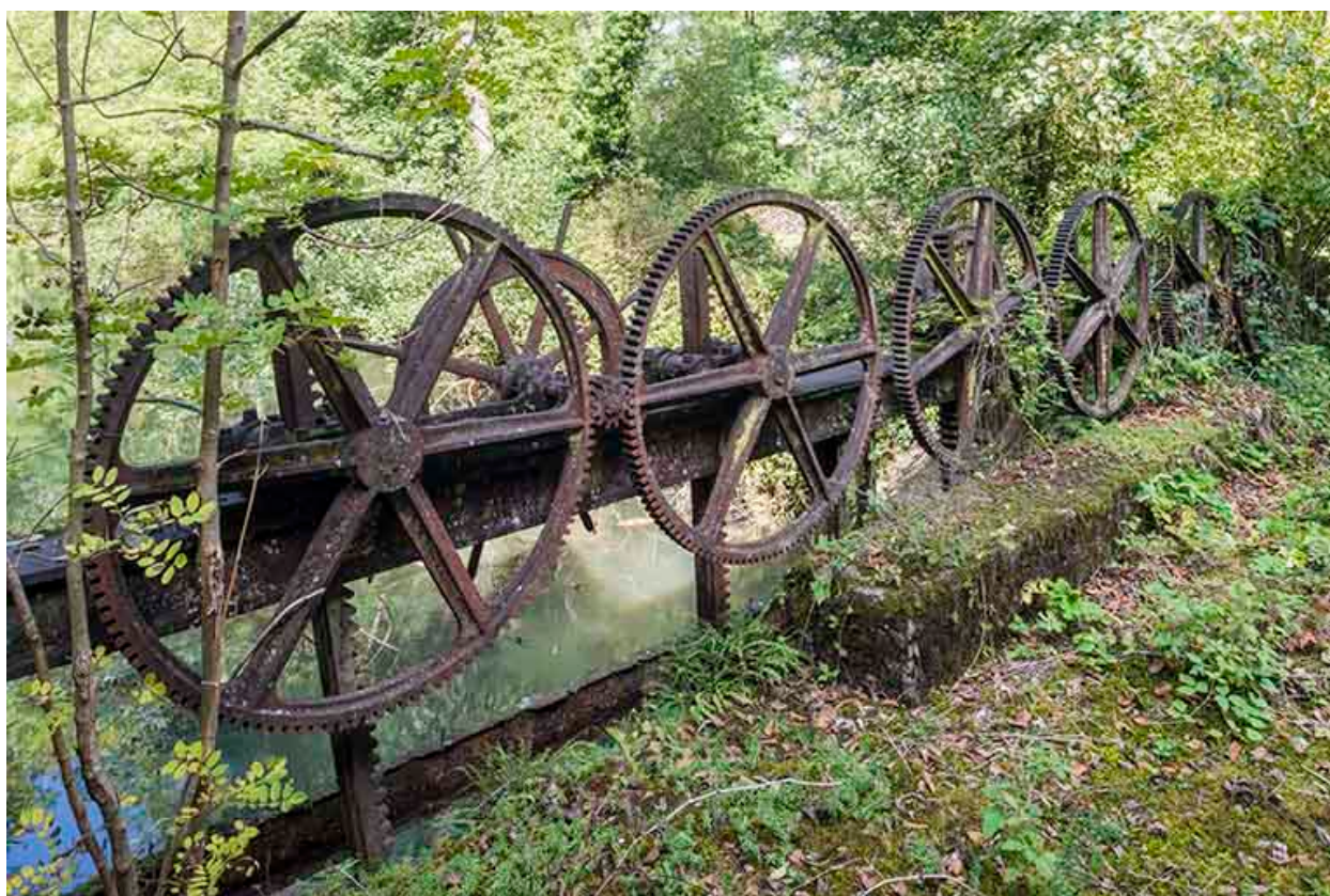
Mécanisme de levage du vannage.
