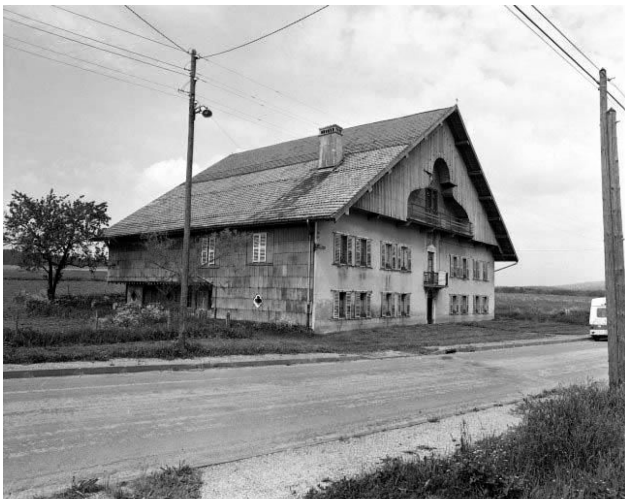
Ferme située rue Condemine.
