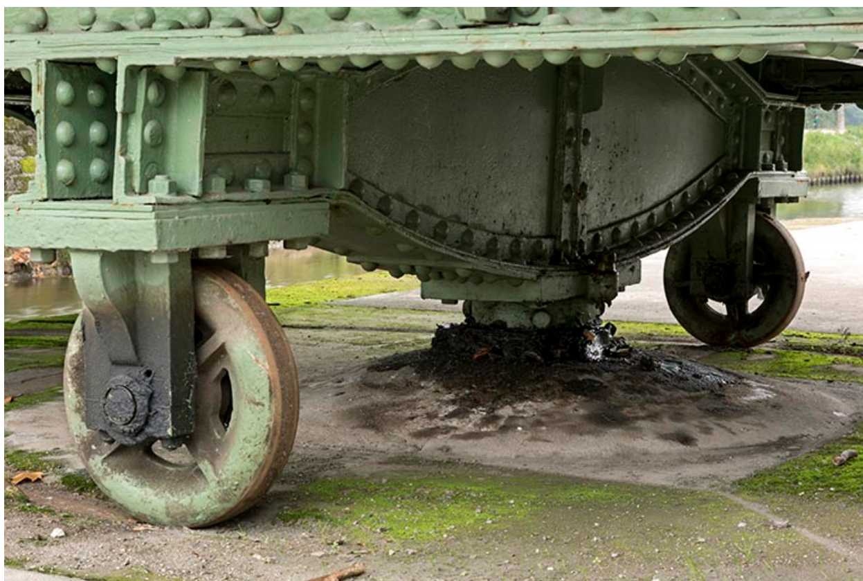
Détail du pivot sous le chevêtre.
