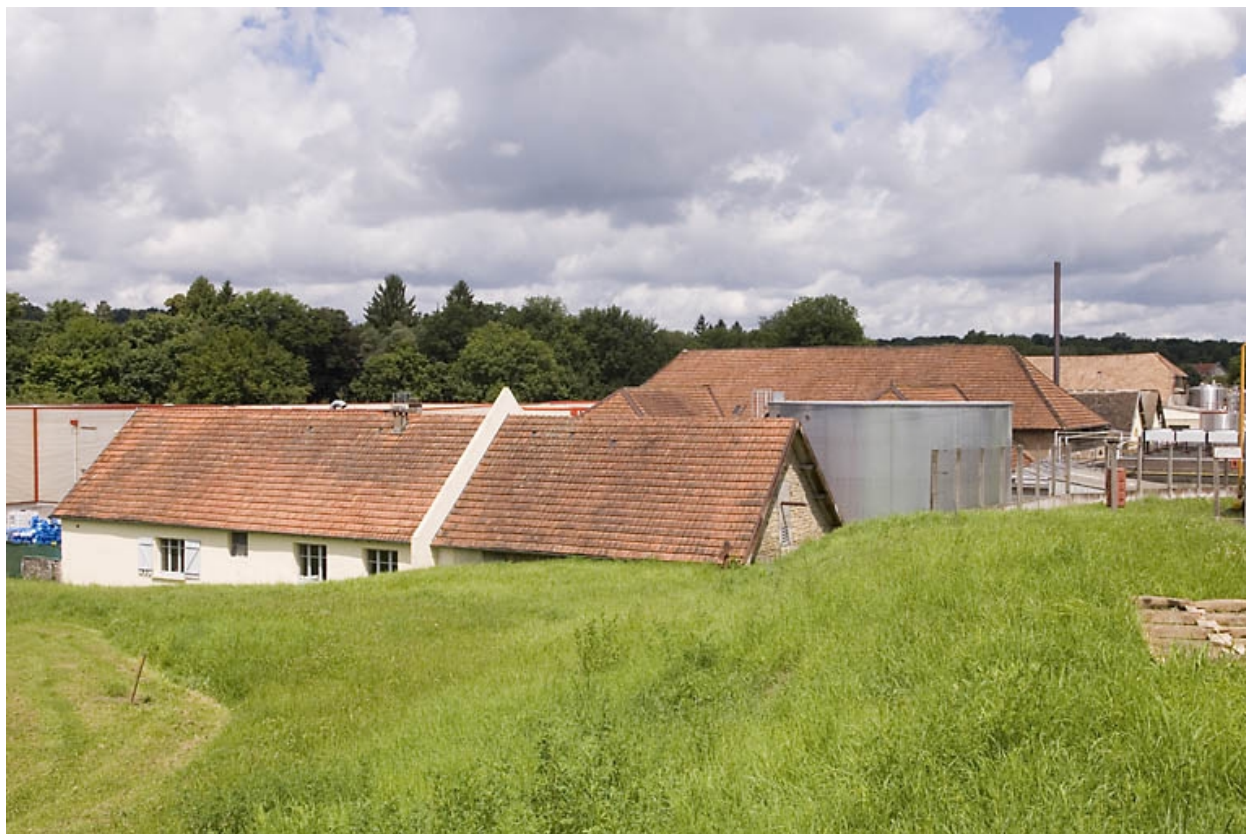
Vue sur les toitures depuis le sud-est.
