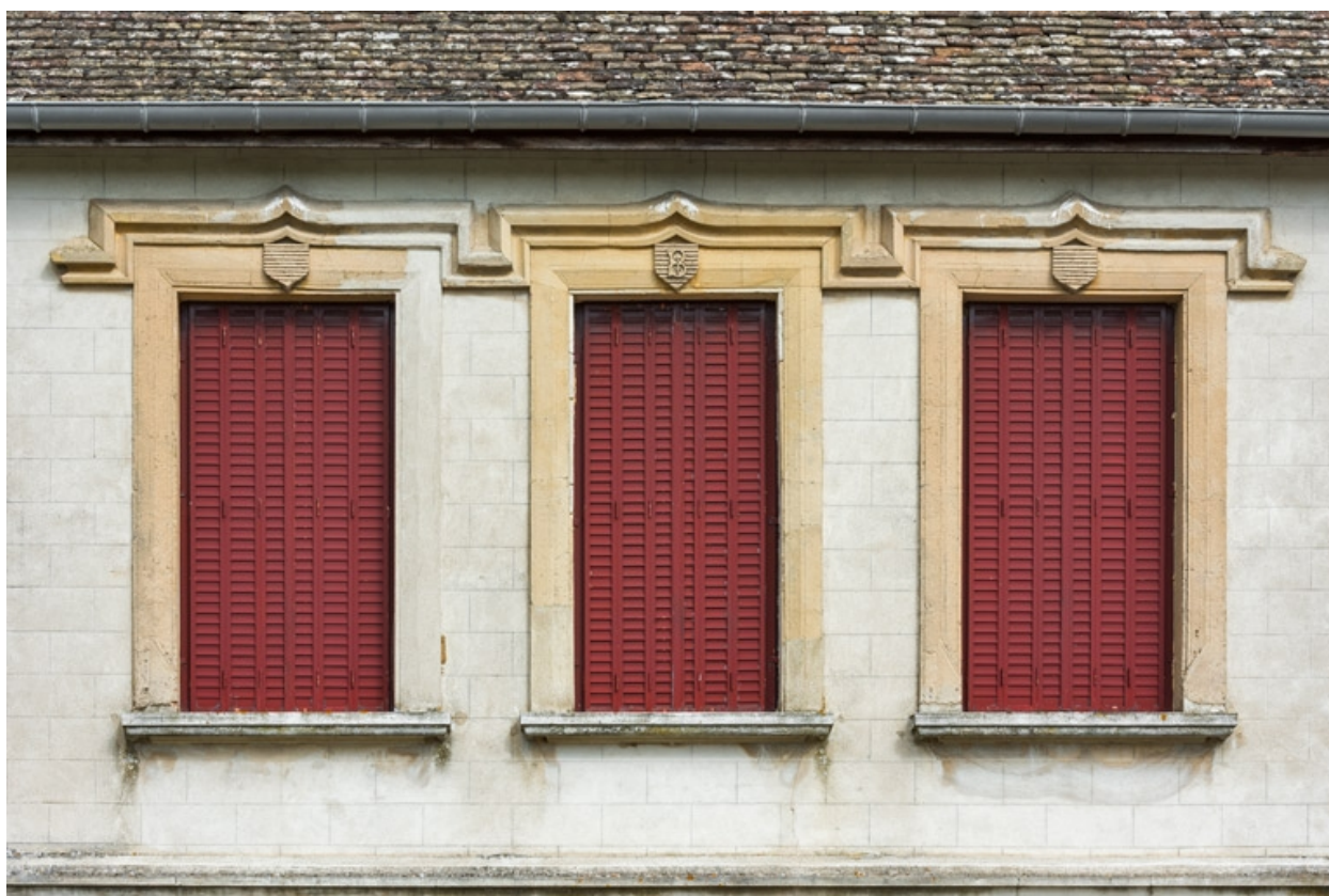
Elévation latérale gauche : baies de l'étage.
