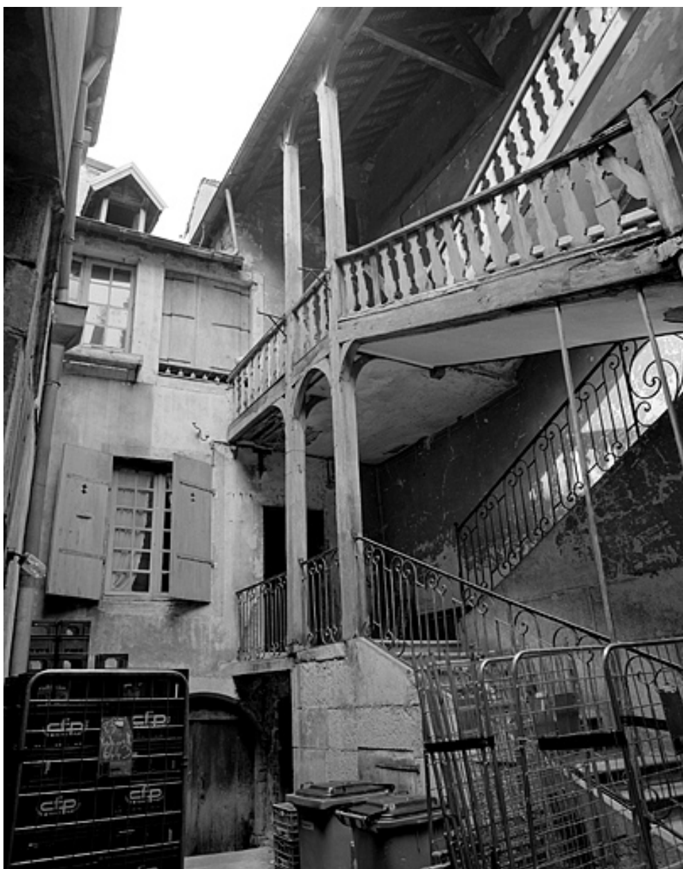
L'escalier s'ouvrant sur la cour.
