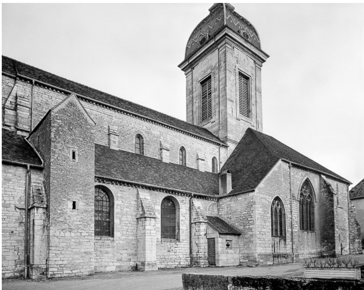
Extérieur : façade latérale sud.
