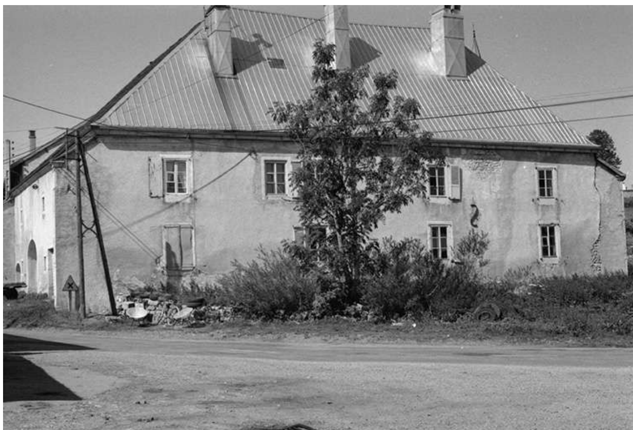
Façade latérale droite.
