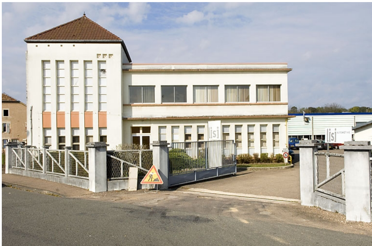
Façade antérieure. Transformateur et bureau.
