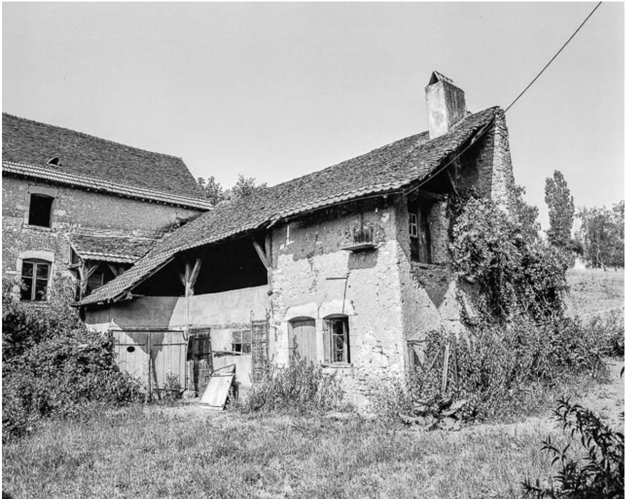
Façade antérieure et aile droite.
