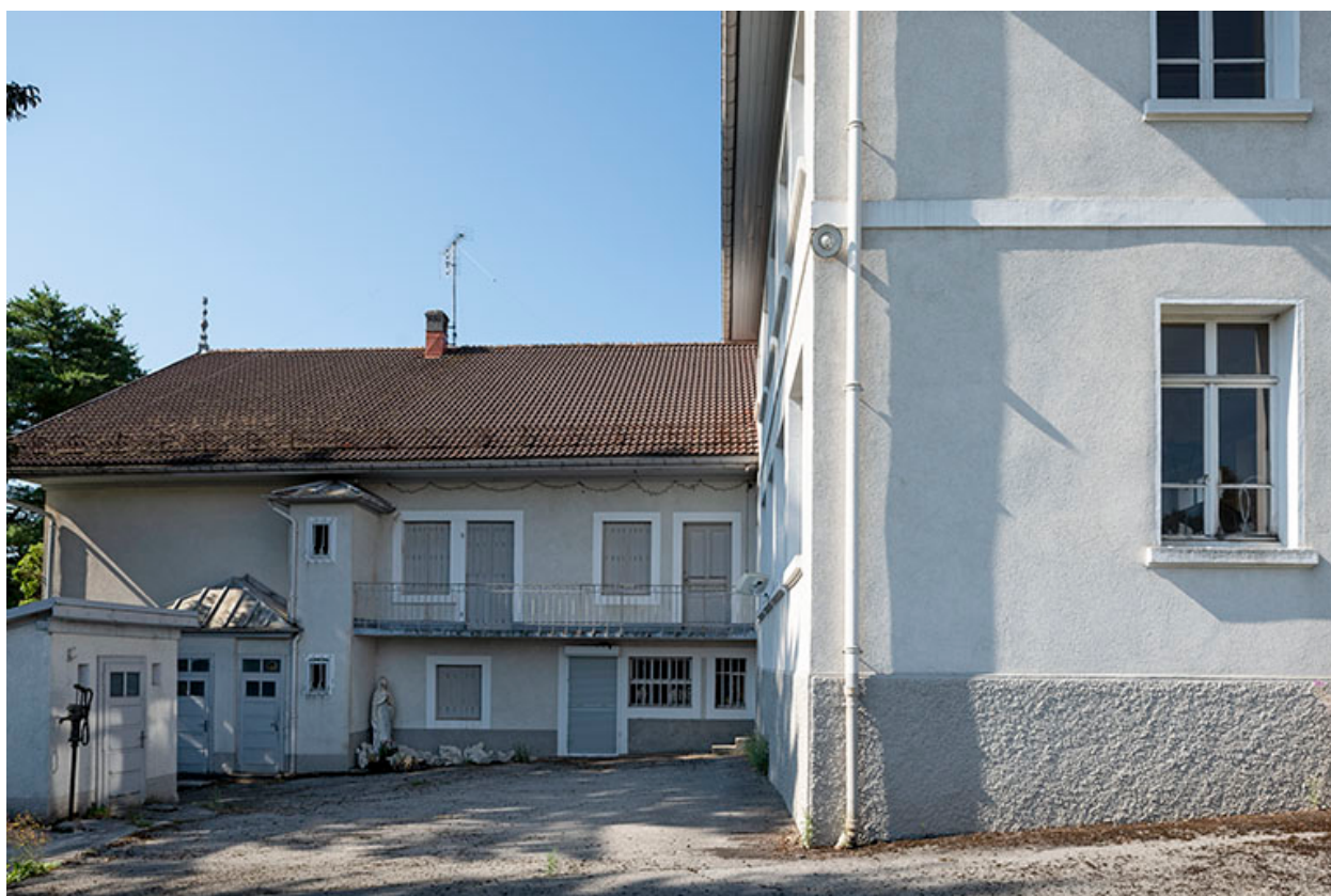
Ancienne ferme : façade postérieure (nord).
