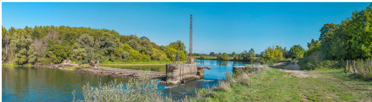
Vue d'ensemble du barrage en 2019.
