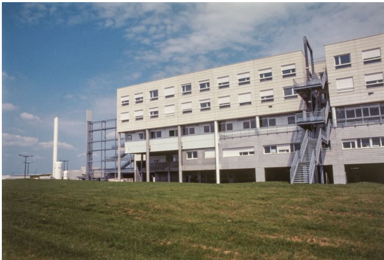
Façade postérieure, partie gauche.
