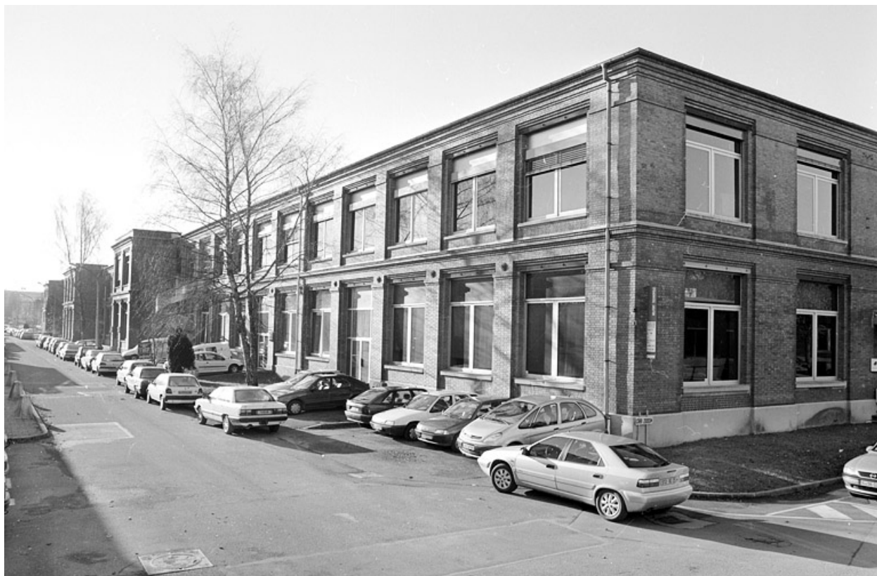
Atelier de finissage : façade est.
