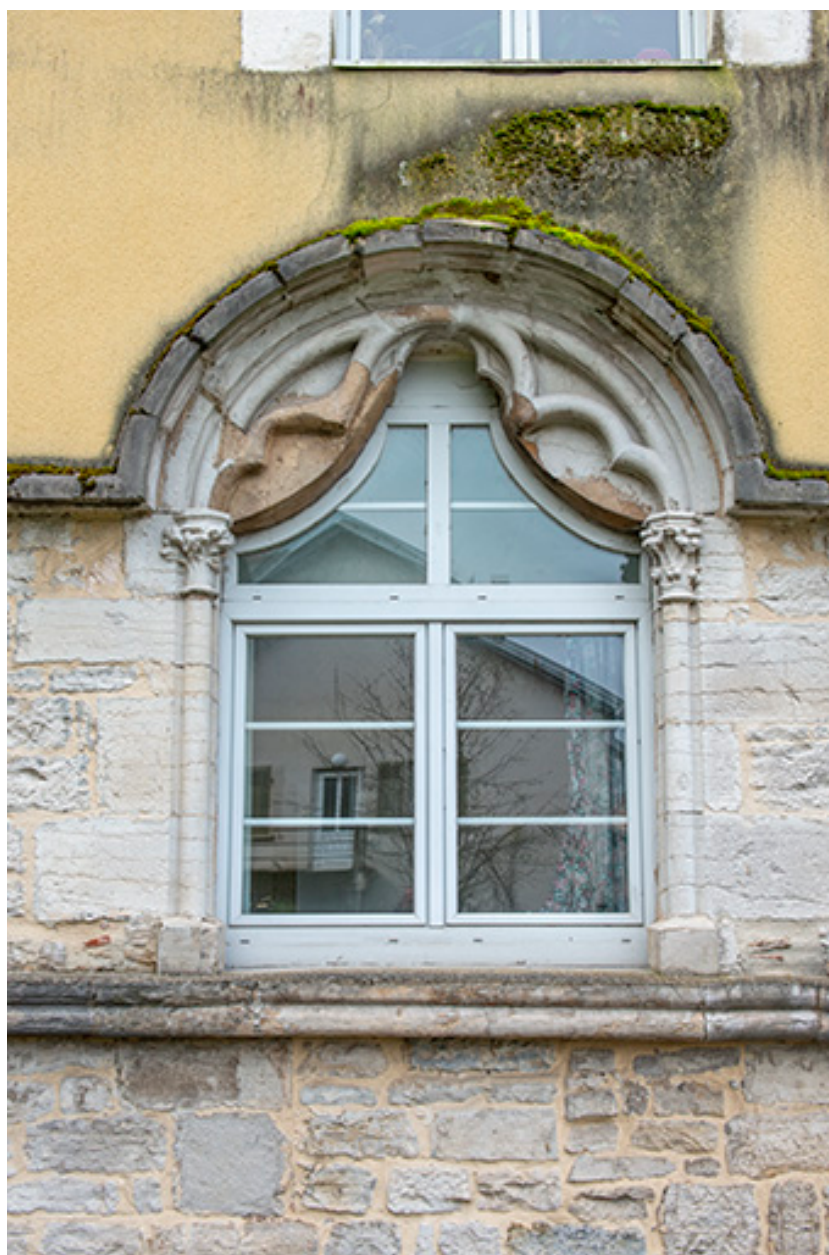
Façade nord. Détail de la fenêtre droite.
