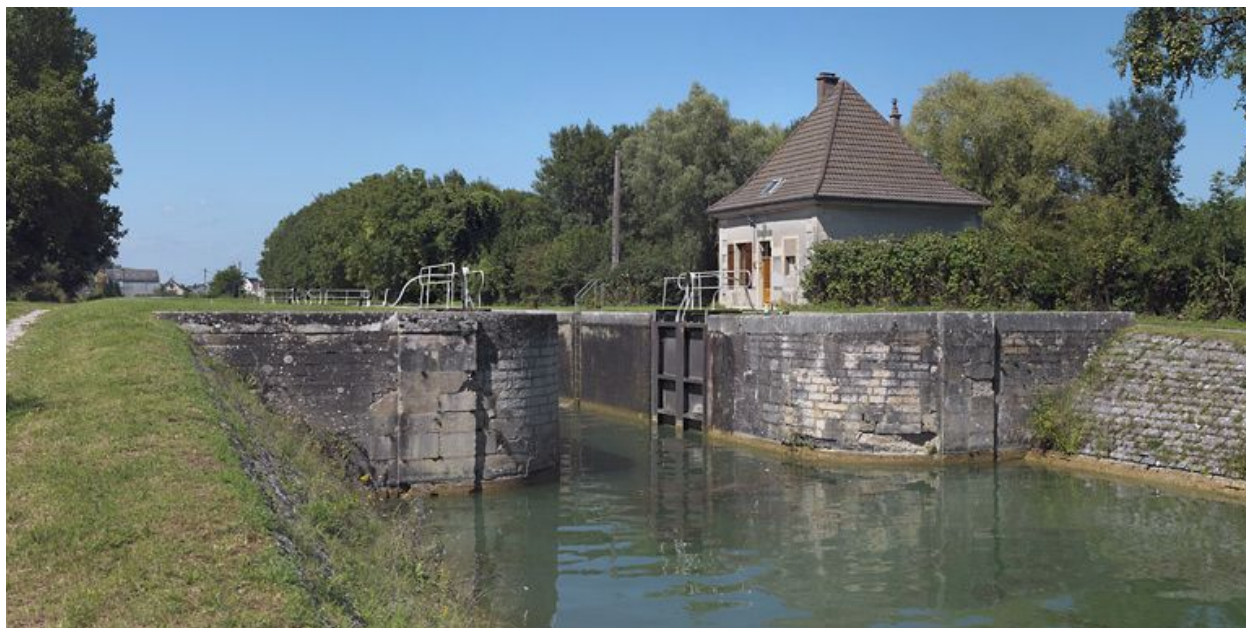
Site vu d'aval.
