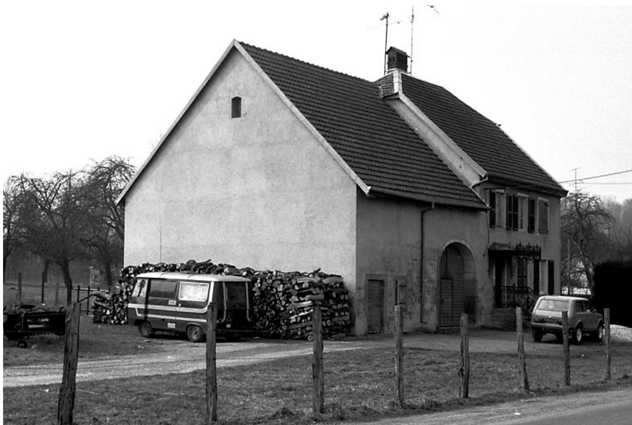
Dasle : ferme située rue de Seloncourt.
