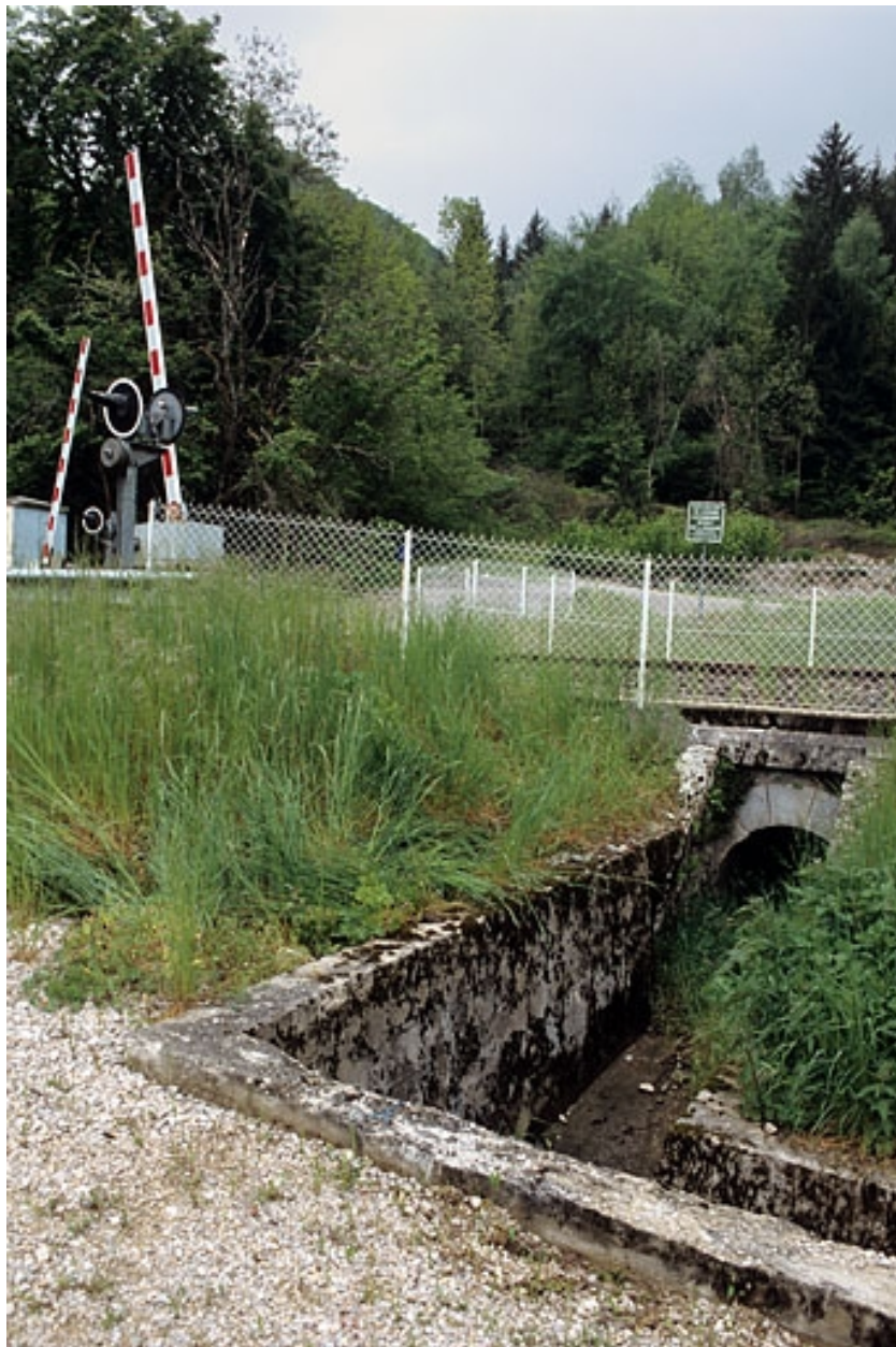
Tête aval (est) de l'aqueduc.
