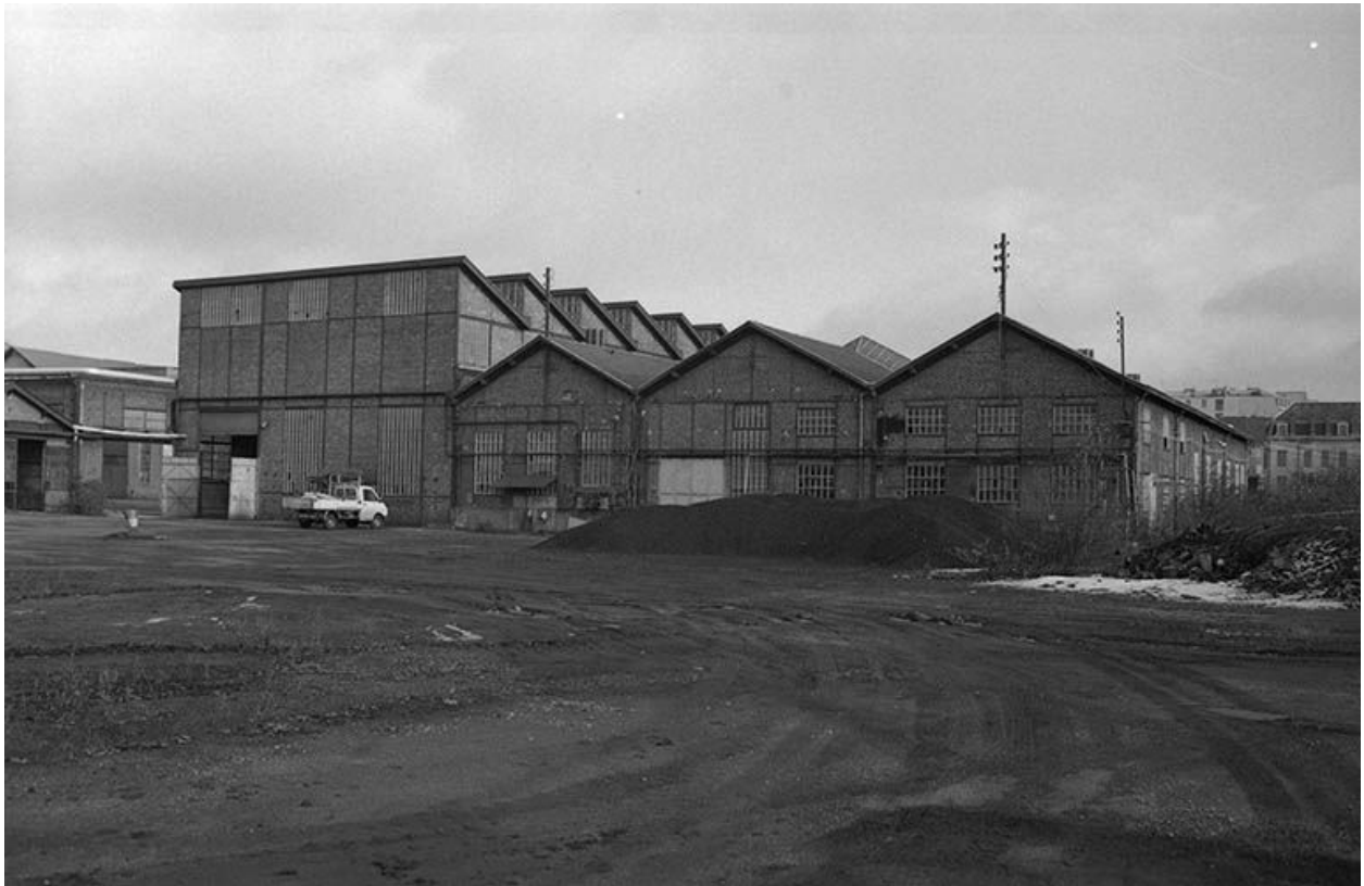
Chaudronnerie vue de l'Ouest.
