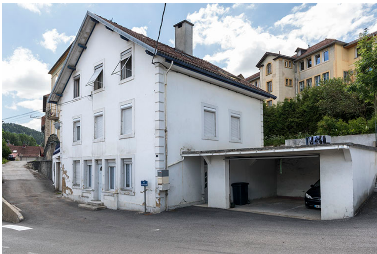
Façades antérieure et latérale droite.
