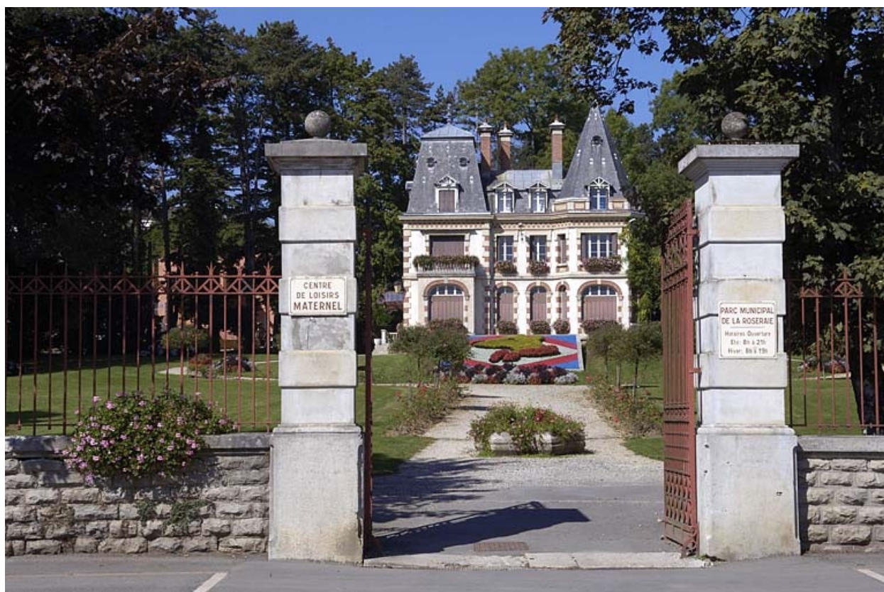
Vue d'ensemble depuis l'entrée du parc.
