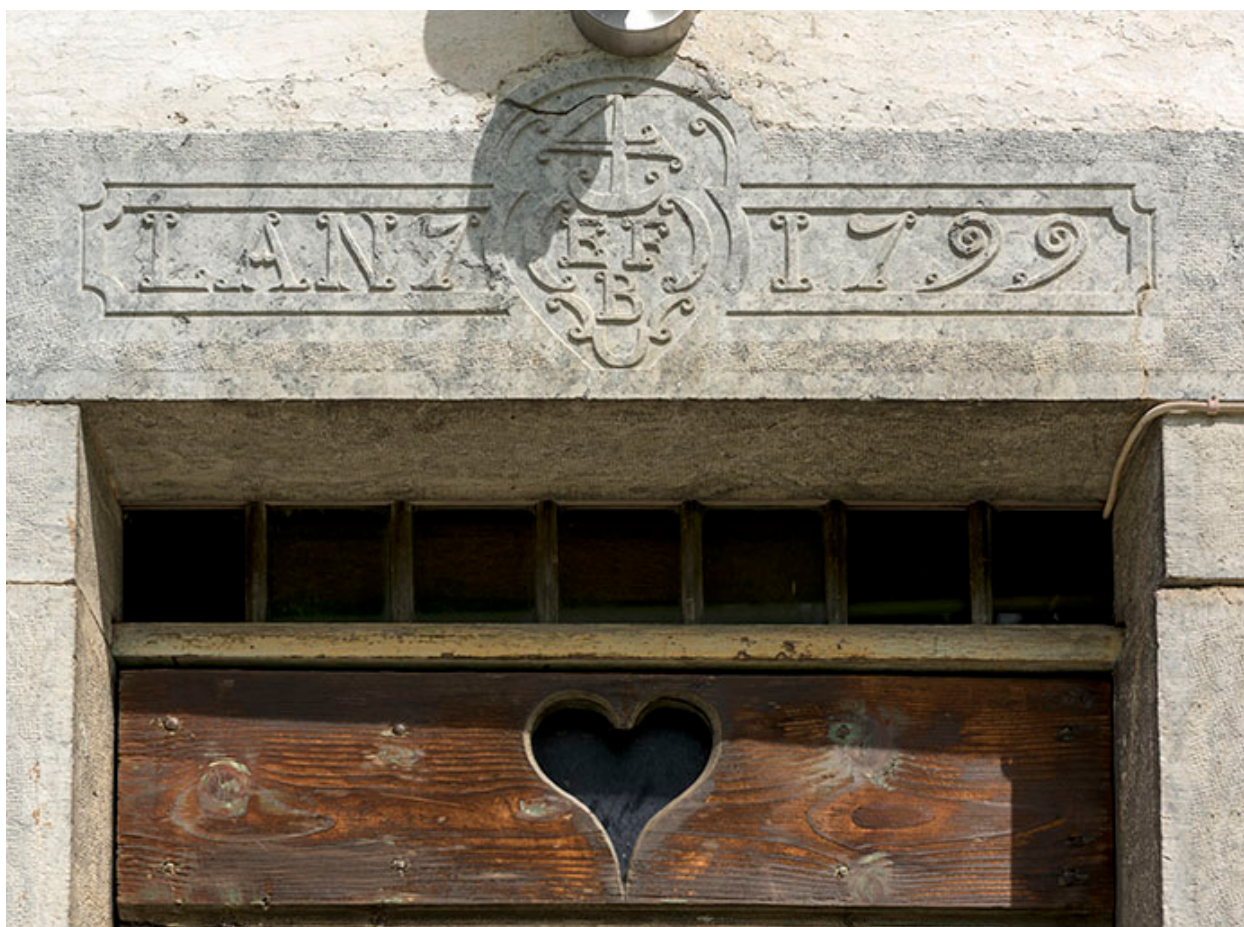
Façade antérieure : linteau daté 1799.
