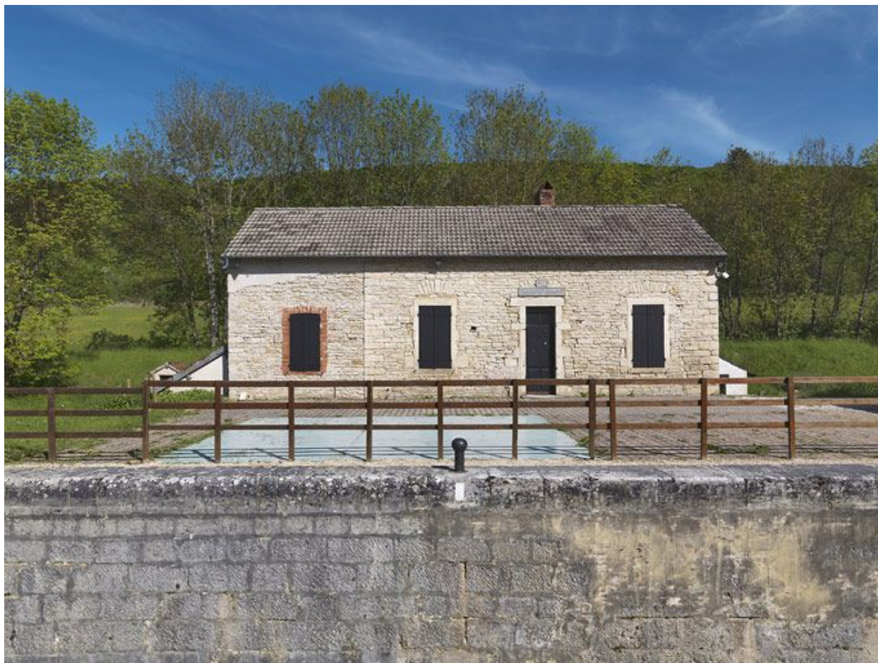
Site d'écluse : maison éclusière vue de face.
