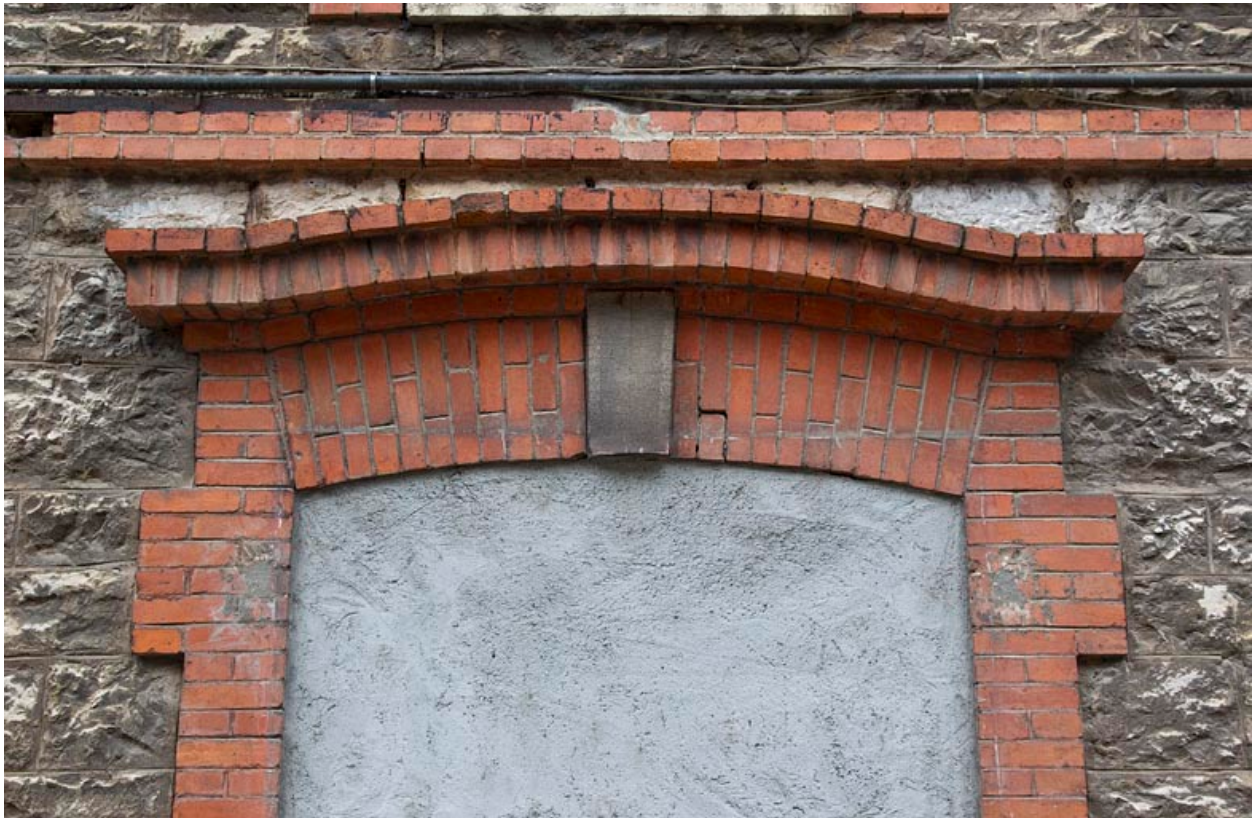
Détail d'une ouverture murée de la distillerie.
