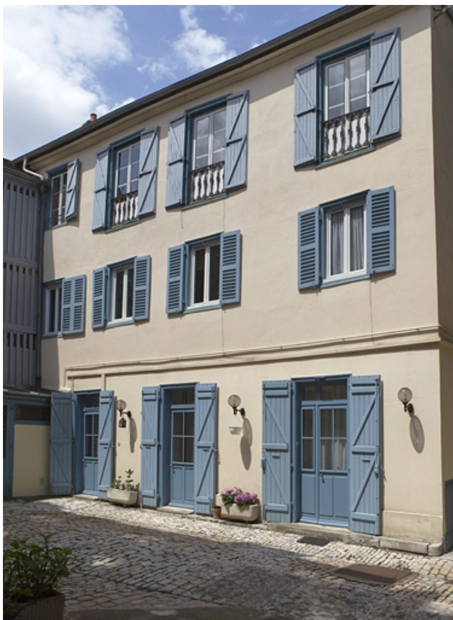
Vue d'ensemble du logis secondaire droit.
