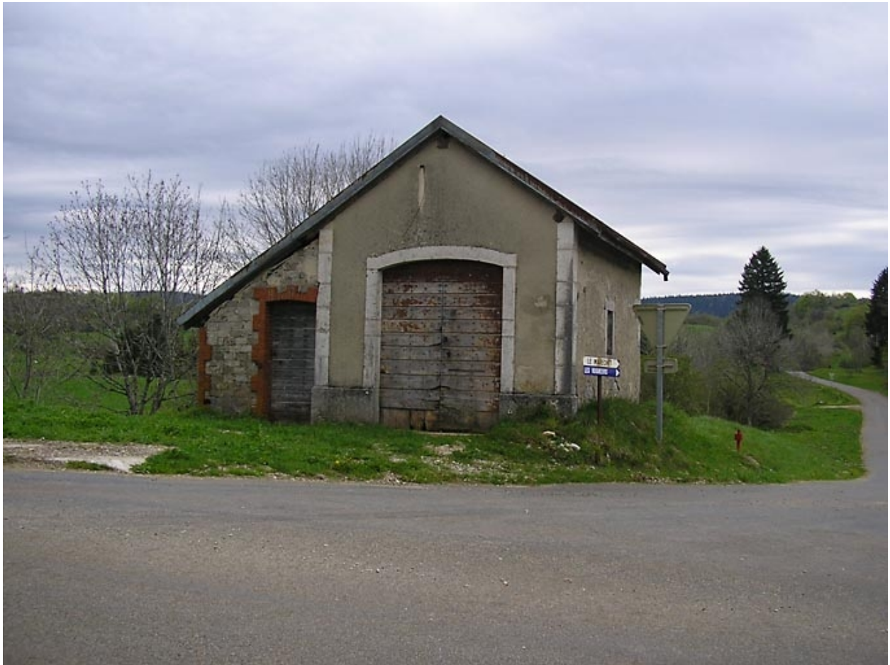
La remise de matériel d'incendie.
