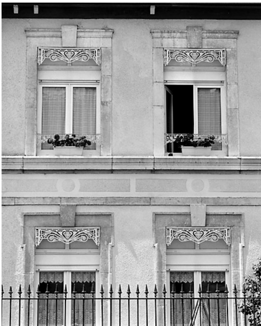
Elévation antérieure : baies.
