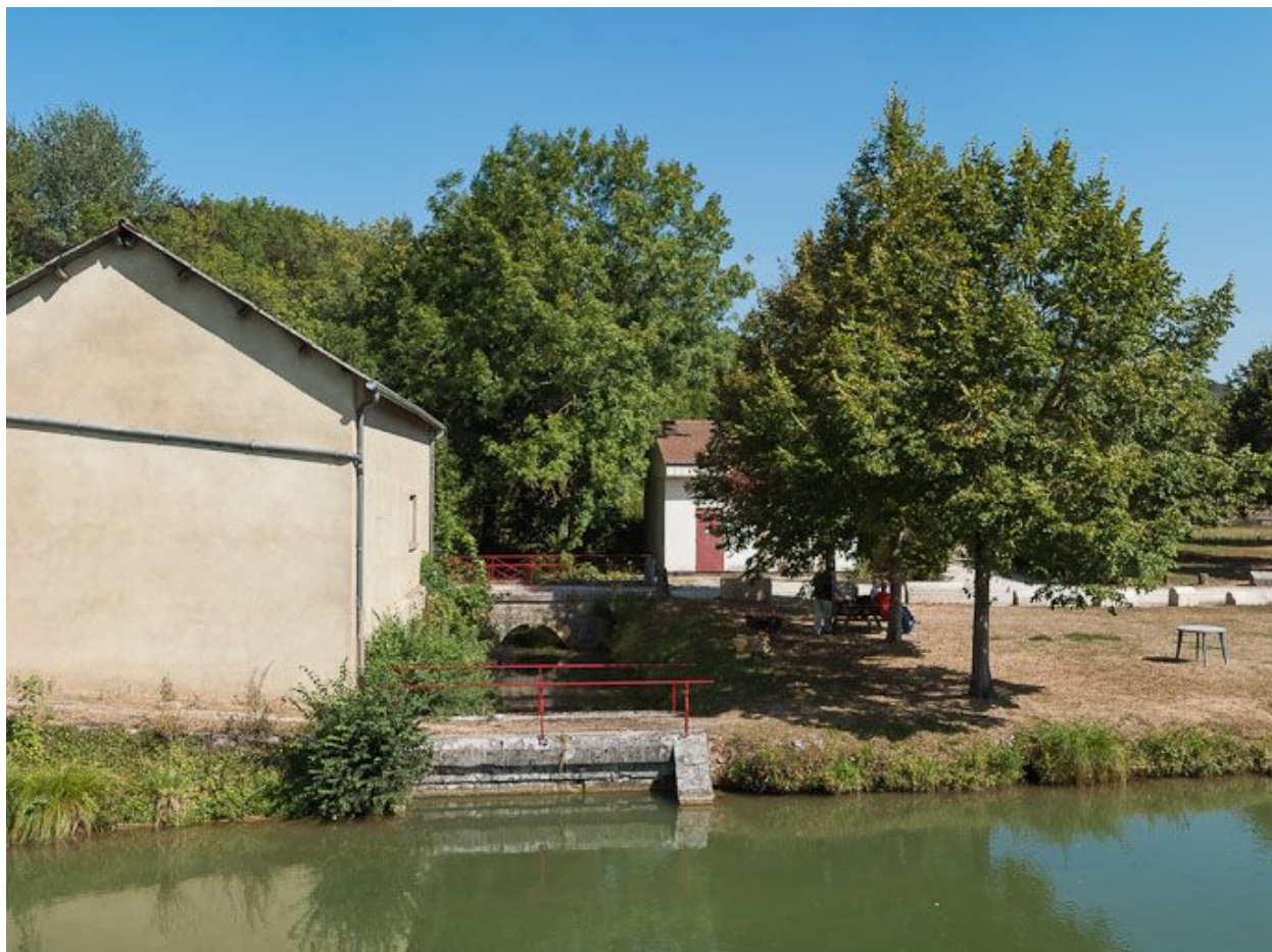
Détail d'un déversoir en aval du port.
