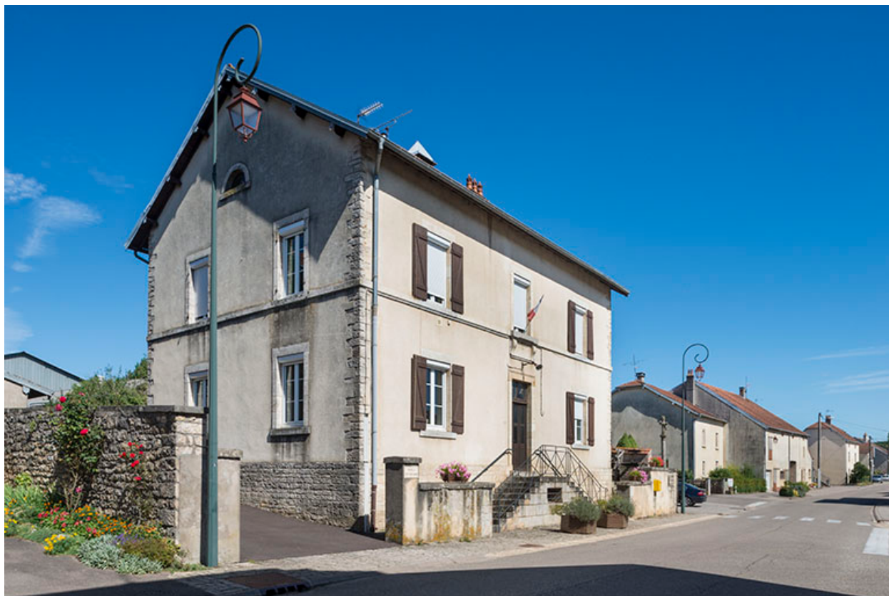
Mur pignon sud de l'édifice.
