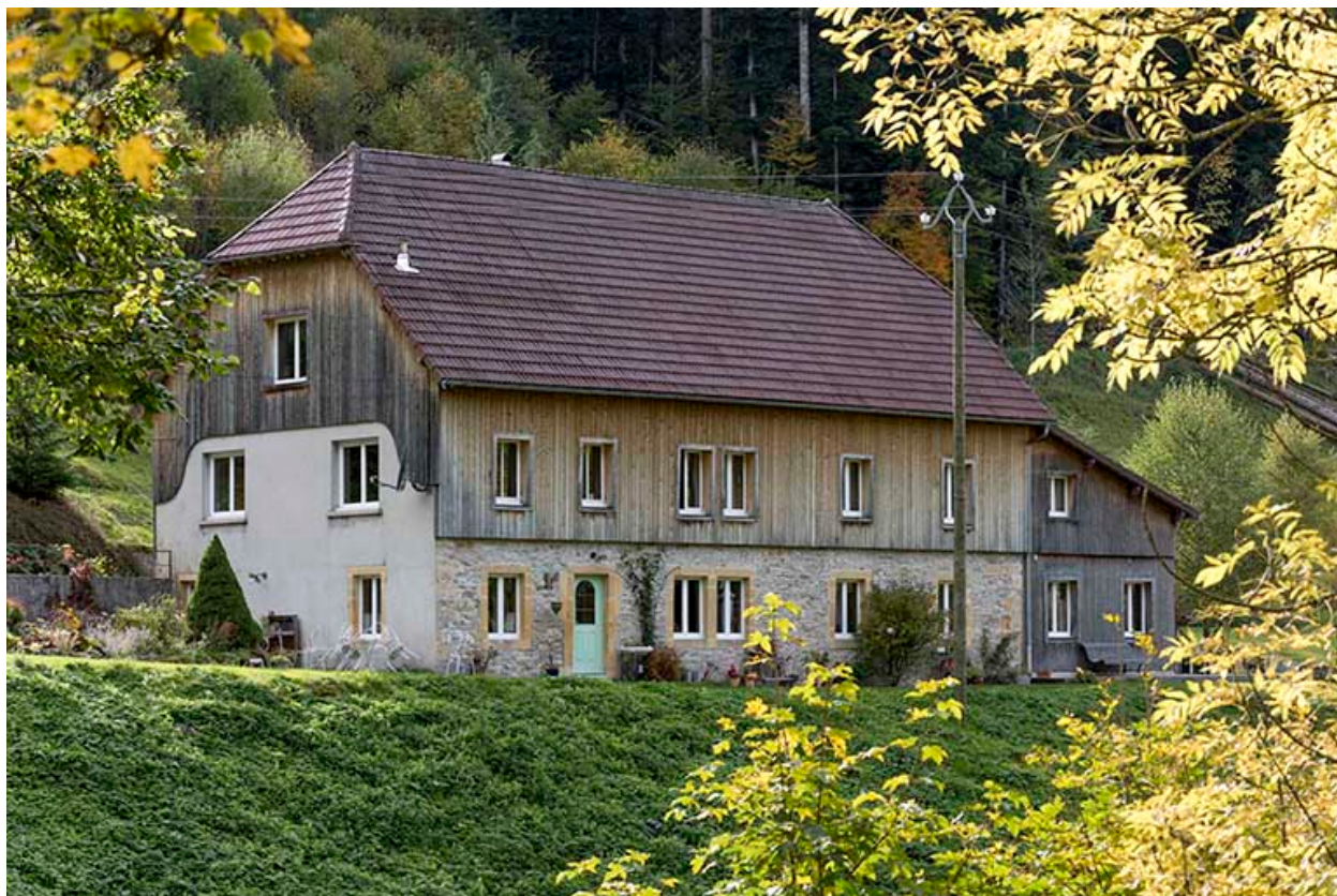
Façades nord et est.
