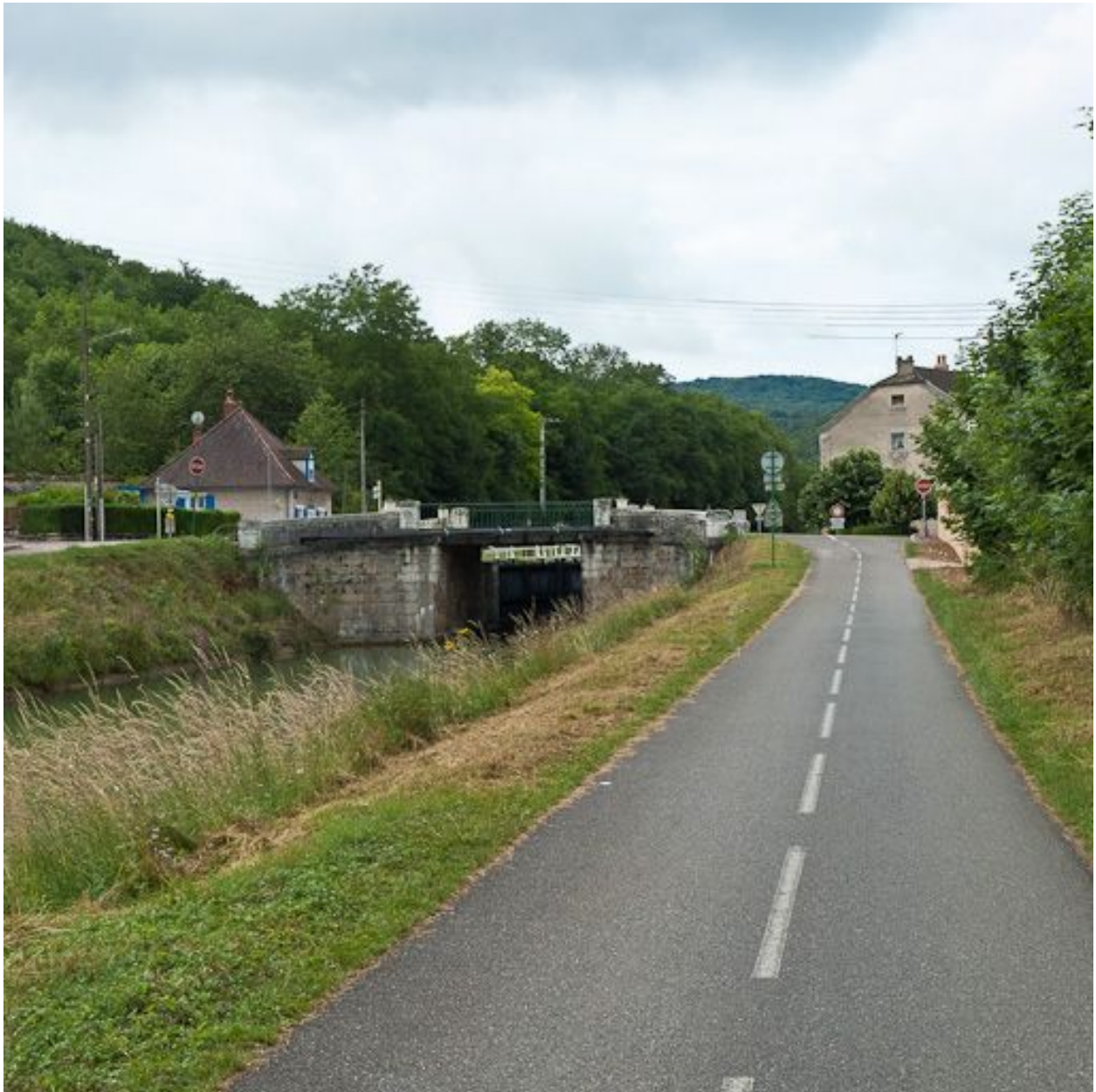
Vue du pont sur écluse depuis l'aval.
