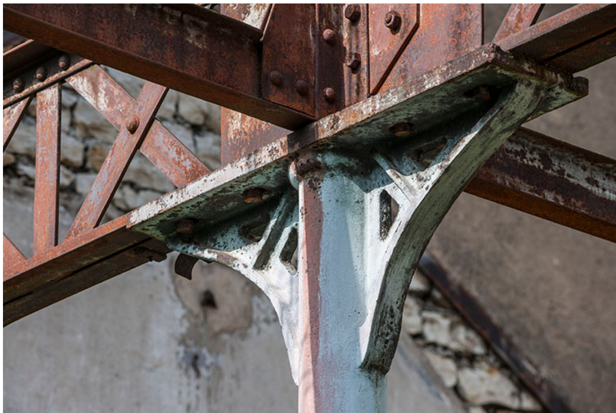
Détail de la charpente métallique.
