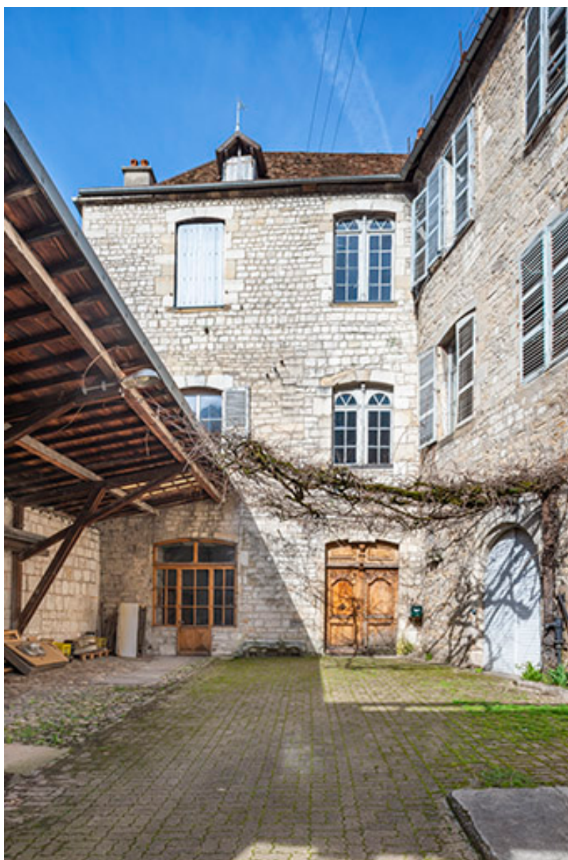
Vue depuis la porte de la cour.
