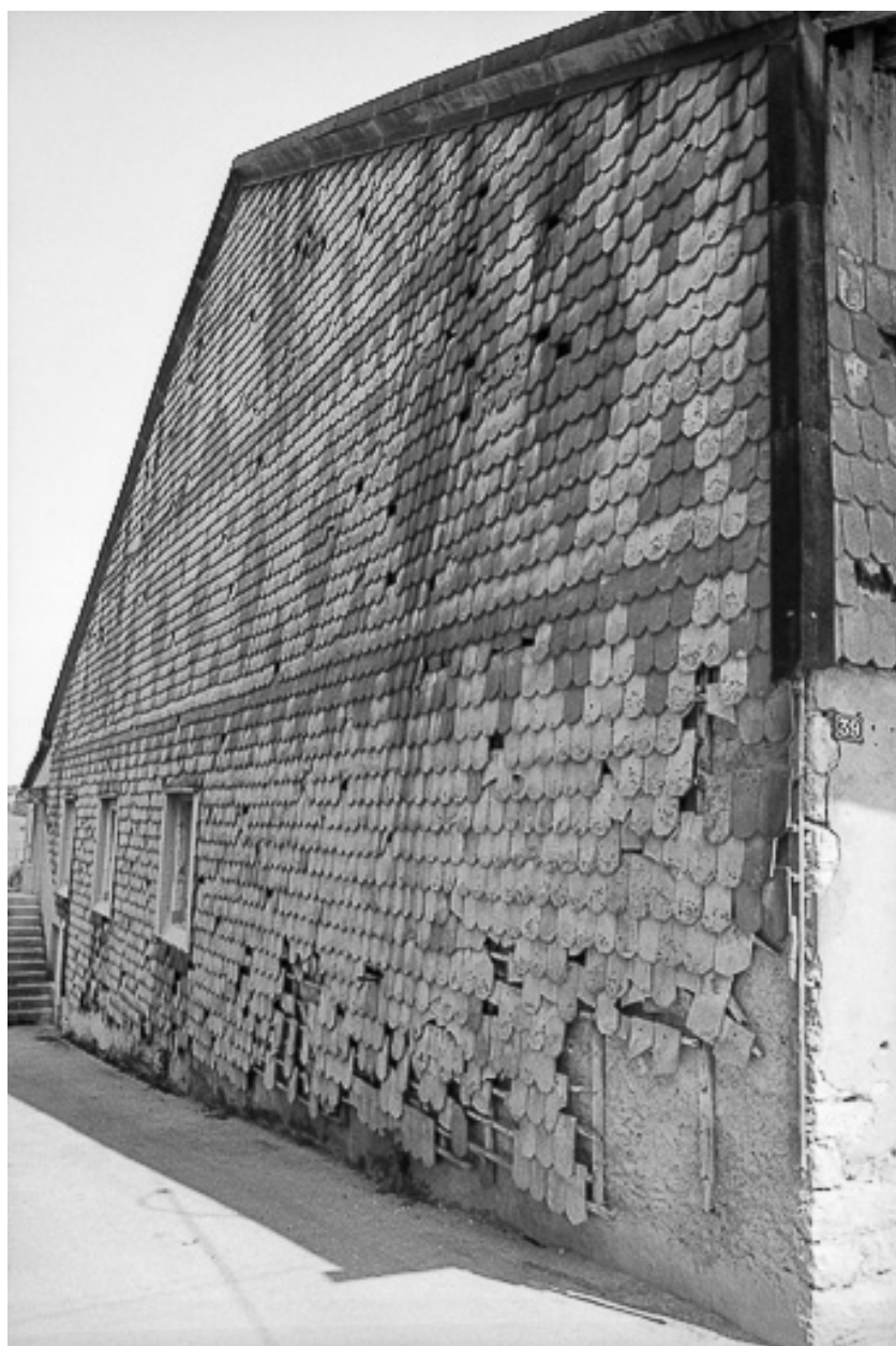
Ferme cadastrée 1962 E 106, 346-347 : façade avec tavaillons.
