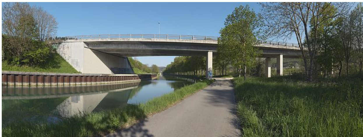
Pont vu d'aval.
