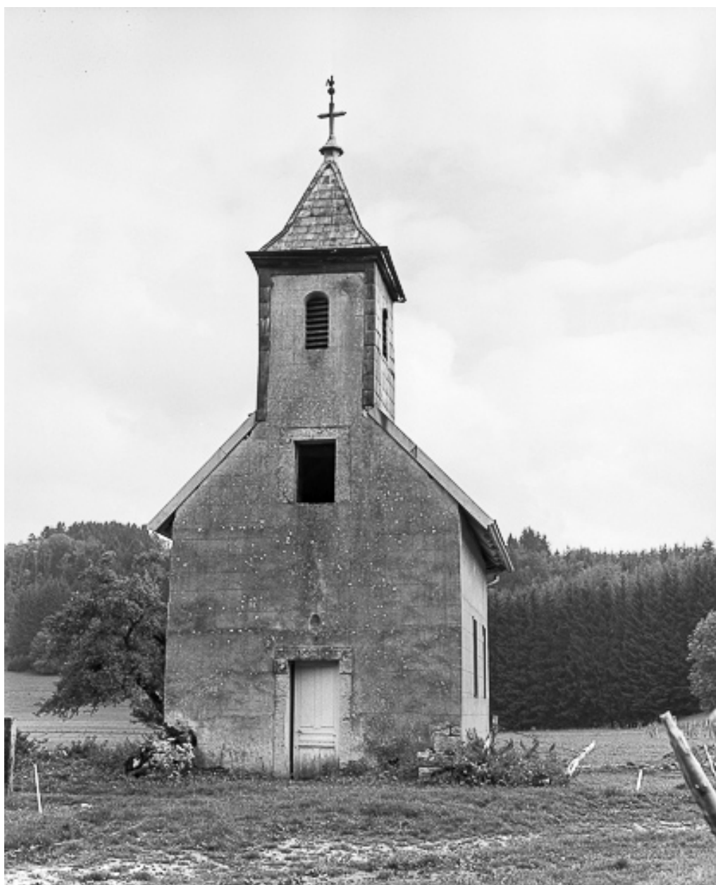
Vue extérieure : façade antérieure.
