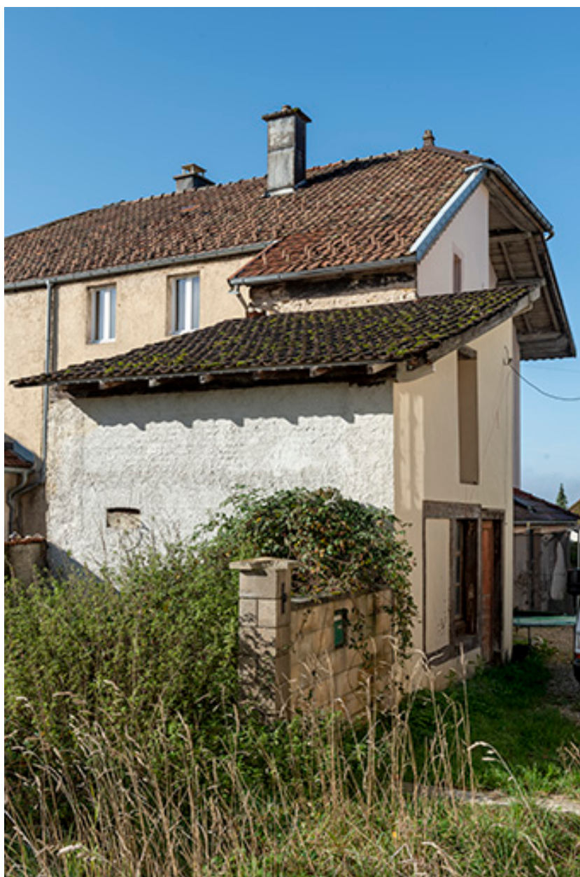
Atelier de fabrication, de trois quarts gauche.
