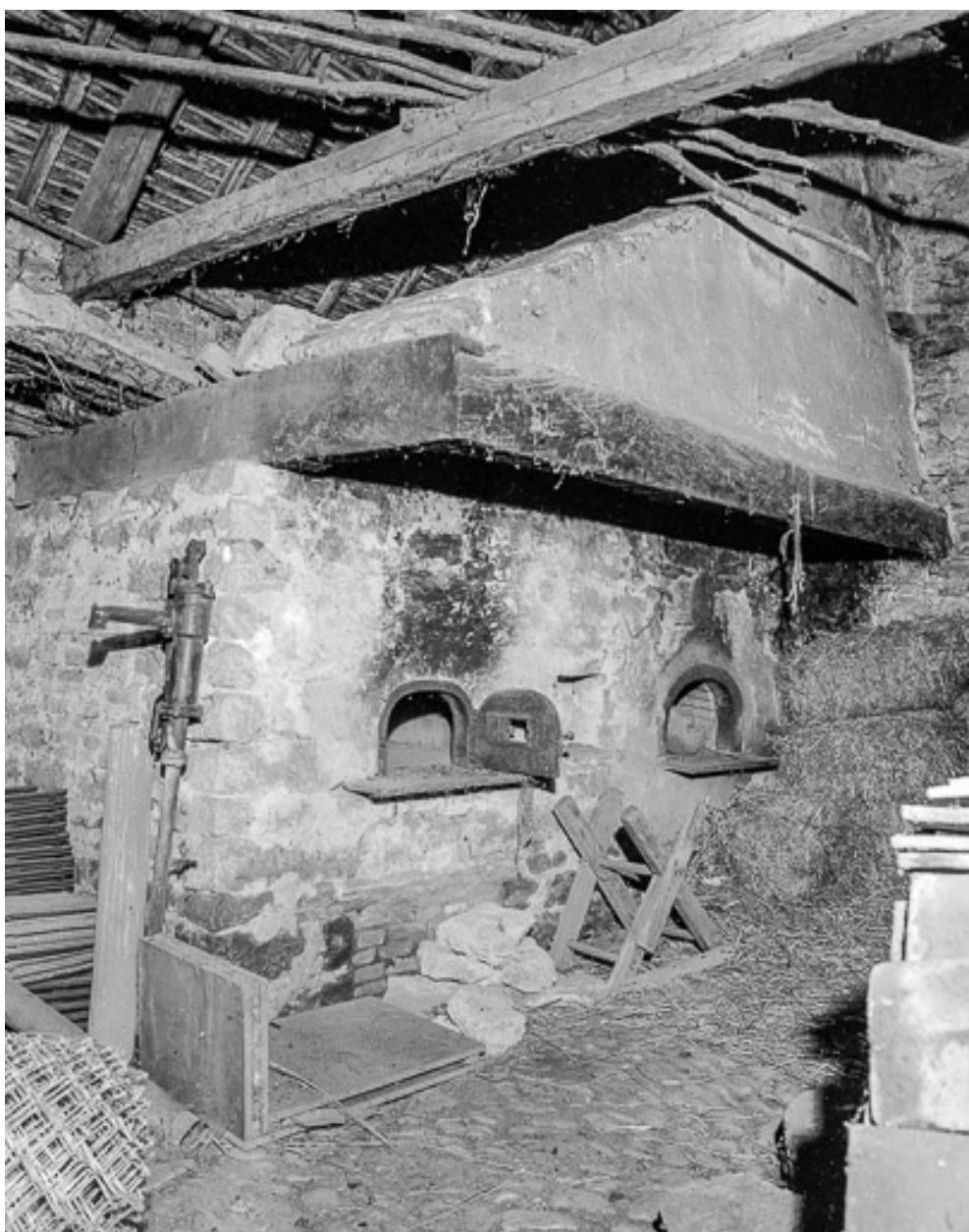
Ferme n° 16 : ensemble de deux fours.
