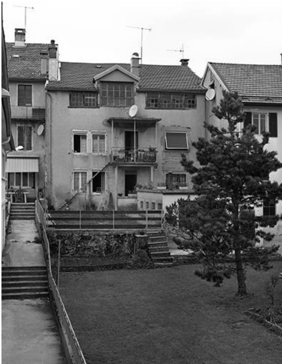
Façade postérieure d'un immeuble.
