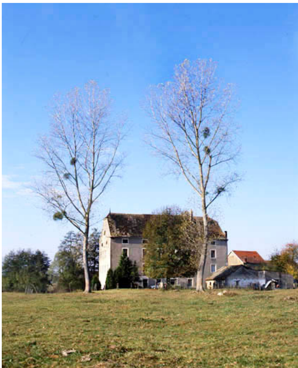
Vue d'ensemble depuis le sud en 1988.
