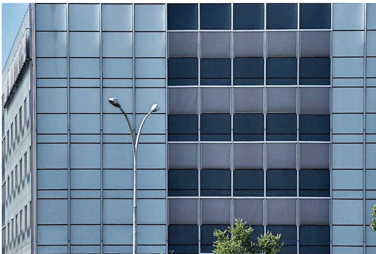
Bâtiment principal, détail.
