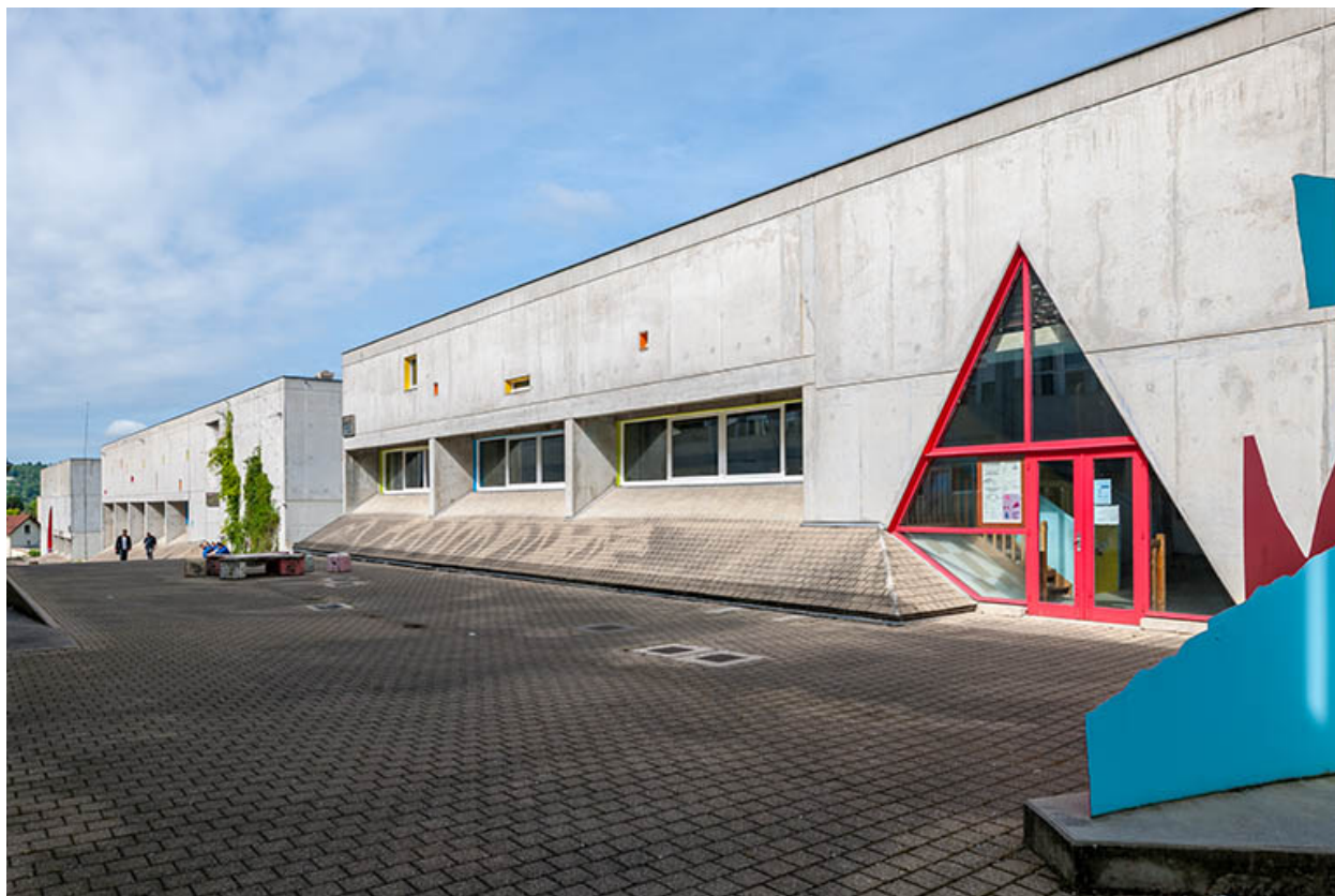
Atelier bois : façade antérieure sur rue intérieure.
