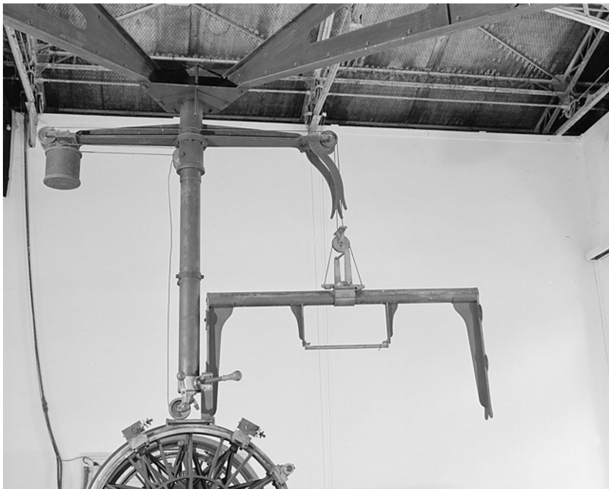
Vue latérale du support du niveau suspendu.
