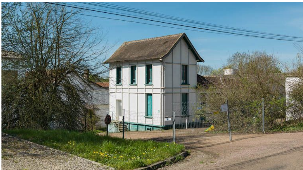
Détail d'un bâtiment de l'entre-deux-guerres.
