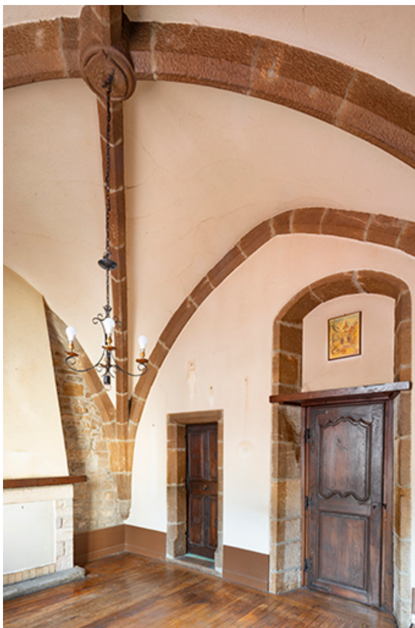
Voûtement de la pièce au premier étage.
