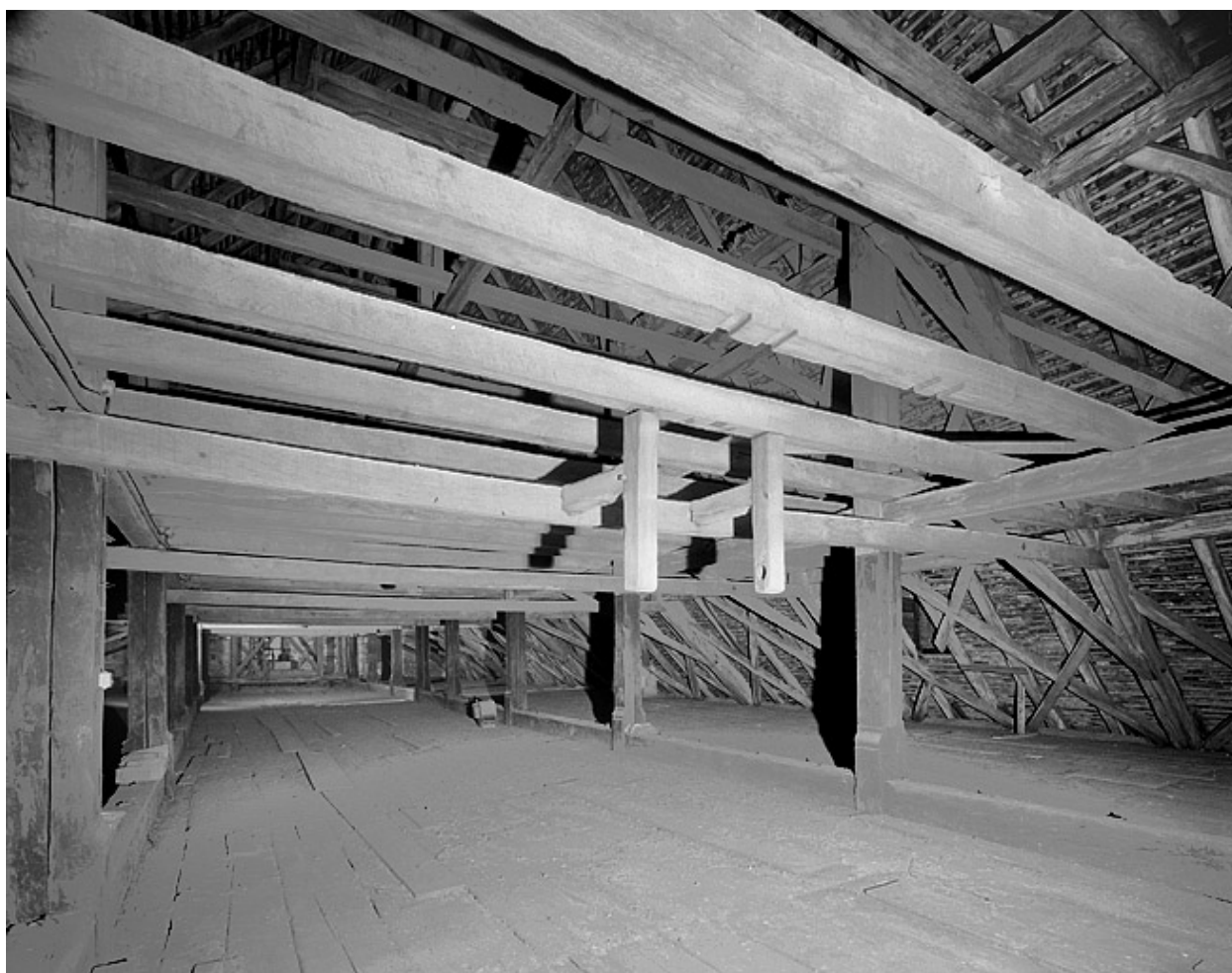
Charpente, vue d'ensemble vers l'est.
