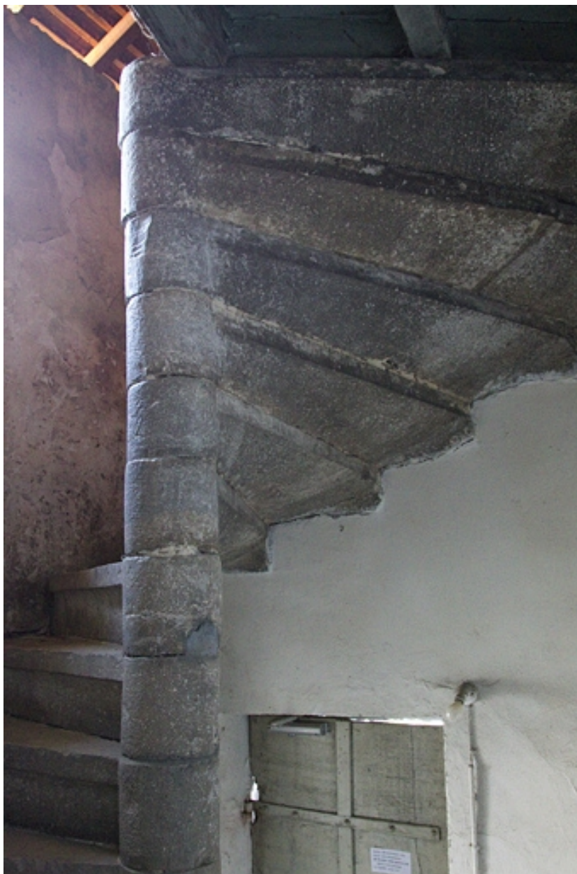
Deuxième logis secondaire : détail d'escalier en vis.
